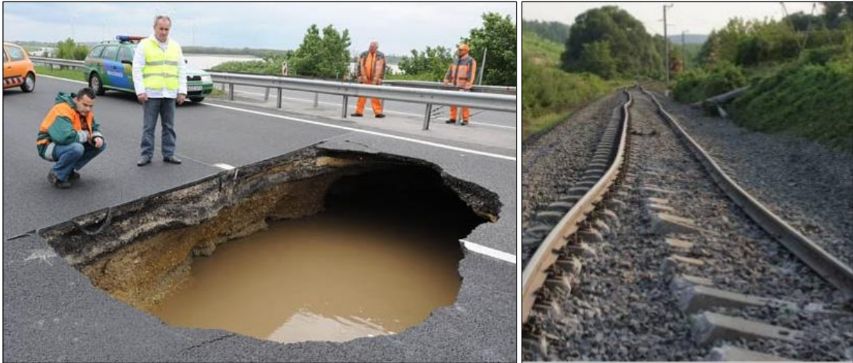
1. ábra: Közlekedési létesítményekben keletkezett jelentős károk (bal oldalon: M1 autópálya teljes pályaszerkezetének beszakadása [Forrás: https://hvg.hu/cegauto/20100519_M1_beszakadt_foto ], jobb oldalon: súlyos sinkivetődés a Kaposvár és Budapest közötti vasútvonalon [Forrás: http://www.kbsz.hu/dokumentumok/2008-335-5_zj.pdf ])
